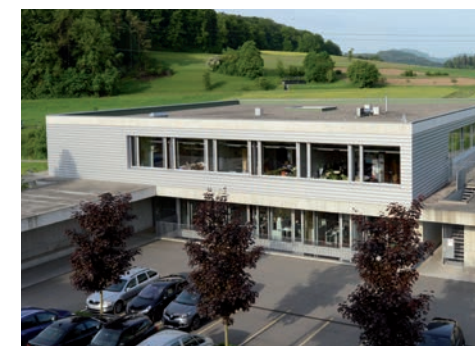
In der Werkstatt Hausen sind verschiedene Abteilungen des Bereichs Arbeiten sowie die Verwaltung untergebracht.
