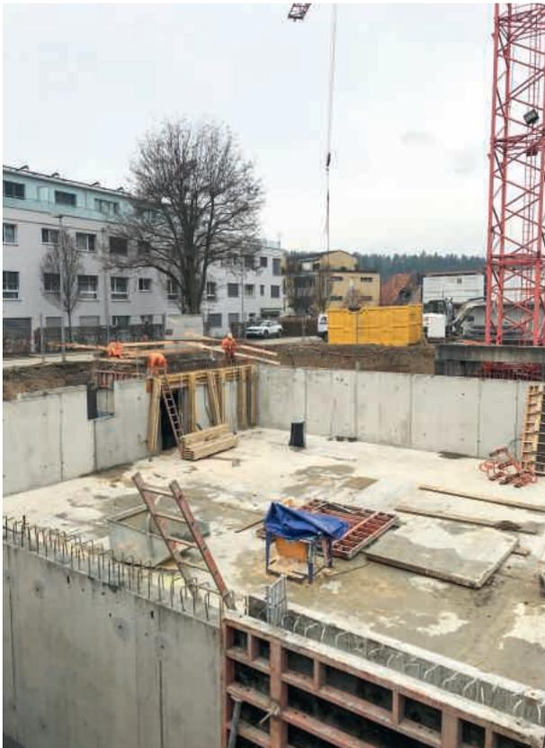
11. Dezember 2020 – Die Umfassungswände zur Einstellhalle und der Trafostation werden gebaut und sind schon fast fertig.
