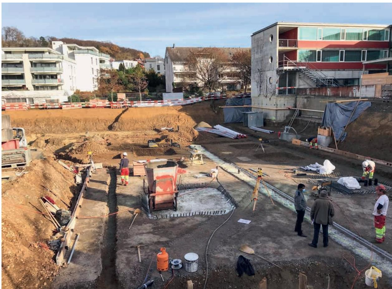
17. November 2020 – Die Baugrubensohle mit den Fundamentvertiefungen der Einstellhalle.
