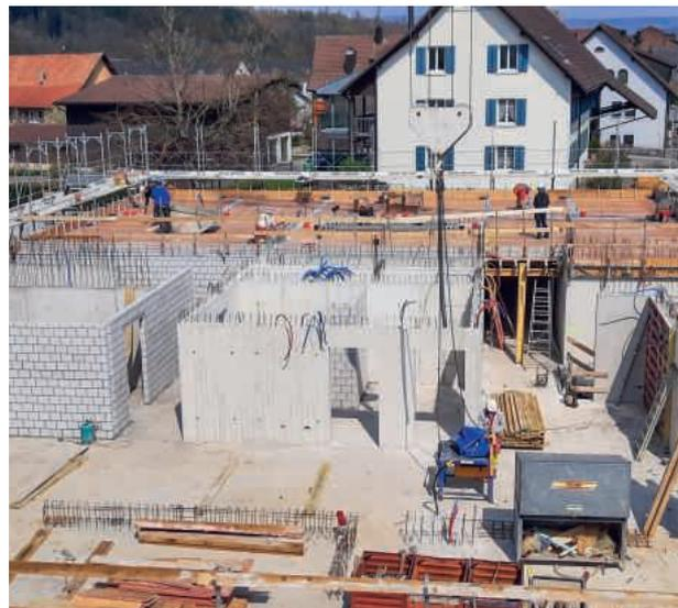
22. April 2021 – Die Innenwände und die Deckenschalung zum Erdgeschoss sind bereits gebaut. (Alle Bilder: Karin Fergg)
