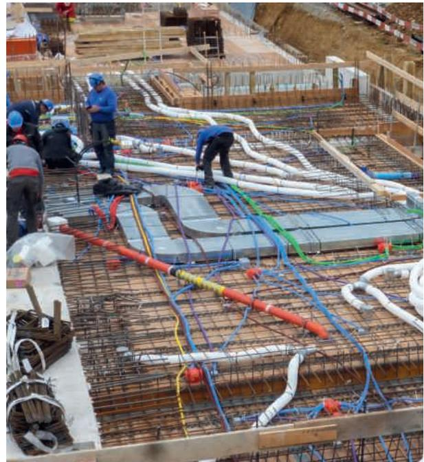
11. März 2021 – Es erfolgt die Montage von meterlangen Deckeneinlagen von Elektro-, Lüftungs- und Sanitäreinlagen.
