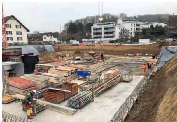
26. November 2020 – Die Bodenplatte ist bereits teilbetoniert und diverses Schalungsmaterial für Wände und Decken bereitgestellt.
